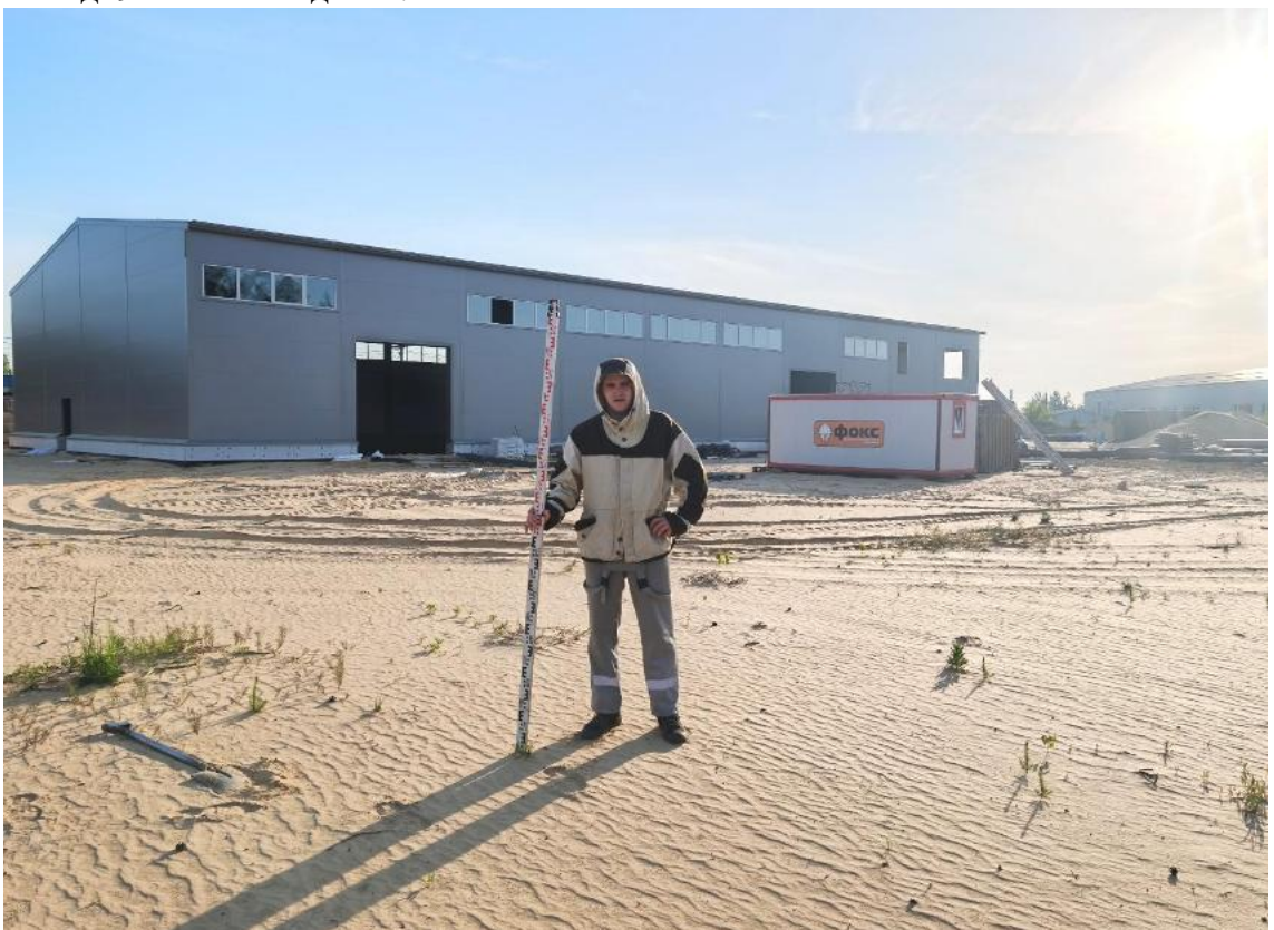
Рис. 10. Объект: земельный участок с кадастровым номером 52:21:0000114:10874 расположенный по адресу: Нижегородская обл., г. Дзержинск, Заревская объездная дорога, в районе д. 9Г. ТФ 1. Вид с ЮЗ.
