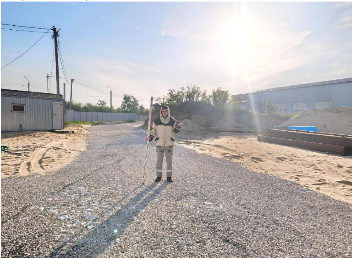
Рис. 18. Объект: земельный участок с кадастровым номером 52:21:0000114:10874 расположенный по адресу: Нижегородская обл., г. Дзержинск, Заревская объездная дорога, в районе д. 9Г. ТФ 2. Вид с З.
