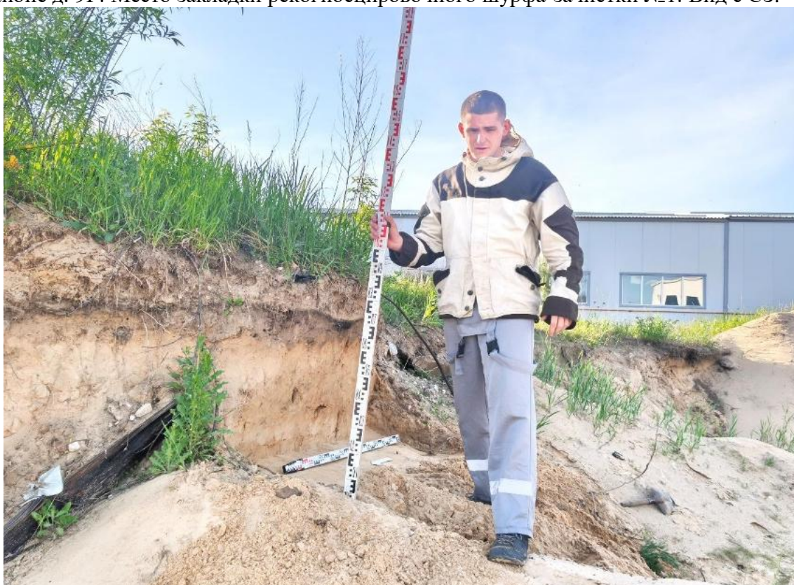
Рис. 38. Объект: земельный участок с кадастровым номером 52:21:0000114:10874 расположенный по адресу: Нижегородская обл., г. Дзержинск, Заревская объездная дорога, в районе д. 9Г. Общий вид на рекогносцировочный шурф-зачистка №1. Вид с СЗ.
